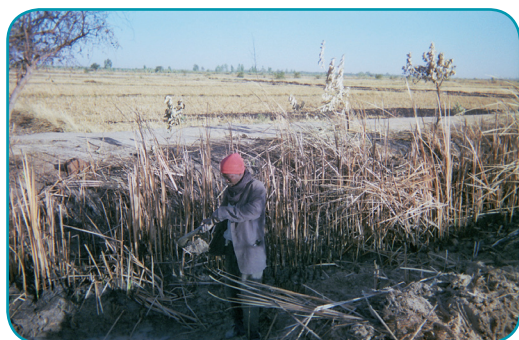
Photo : Curage et faucardage manuel d'un drain tertiaire après brûlis.
