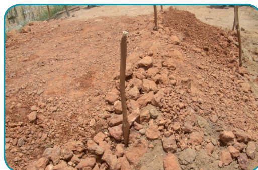
Photo : Apport de différents matériaux (latérite et rochers) et piquetage.
