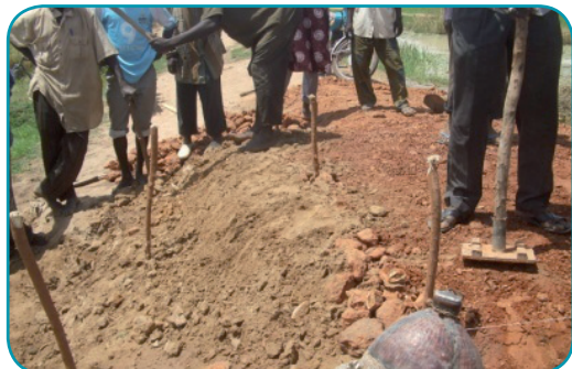
Photos : Piquetage sur un talus. Les différents matériaux sont visibles sur la photo.
